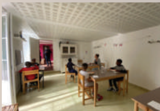
Salle repas après isolation phonique
