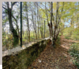
Installation partielle de la clôture sur 240 mètres - TIGERY
