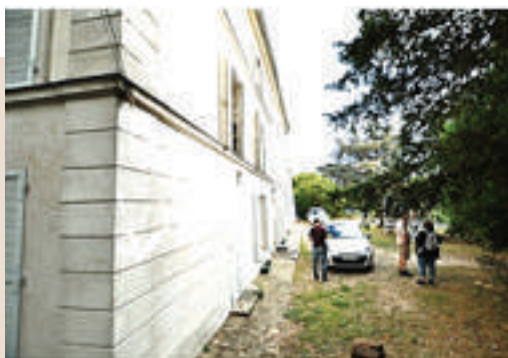
Rossini - Terrassement avant travaux
